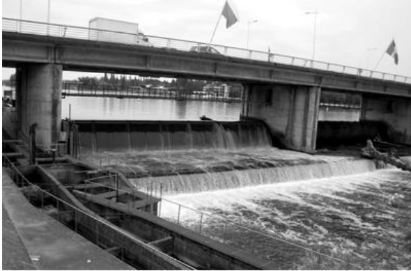
Photo 1 (barrage avec passe à poissons)
