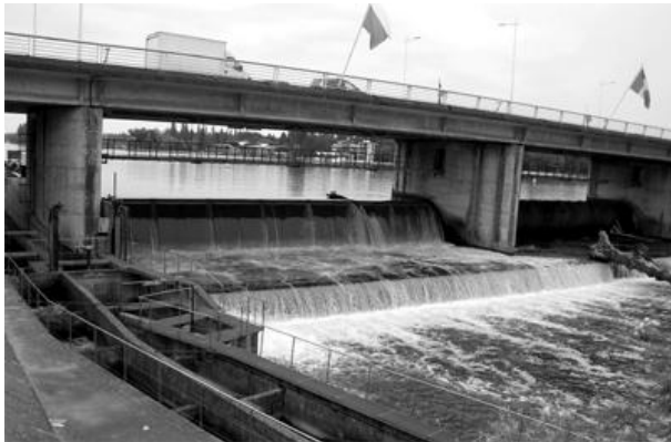
Photo 1 (barrage avec passe à poissons)
